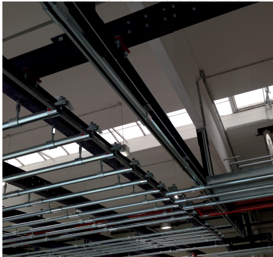
zajištění kolejnic přesuvny
