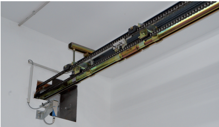
průchod pro dráhu ve stěně
