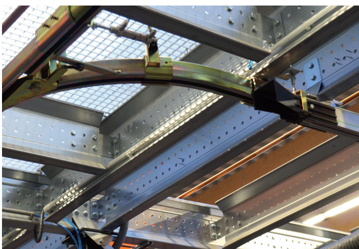
výhybka pneumatická/pracoviště s přívodem el. energie
