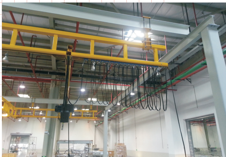
dokončení montáže jeřábového systému s kabelovou vlečkou
