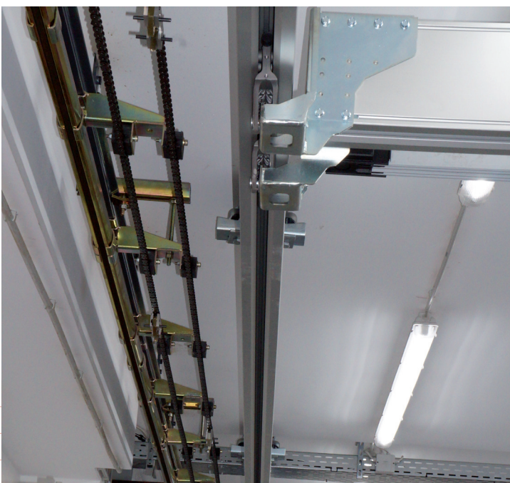
automatické vrácení prázdných traverz
