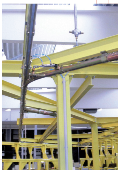
prázdné traverzy určené k zaplnění
