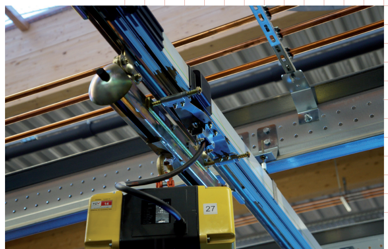
kladkostroj s přívodem el. energie
