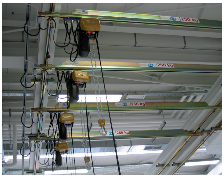
napojení kabelů na trolejové vedení
