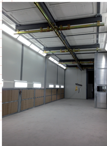
podvěsná dráha v lakovací kabině
