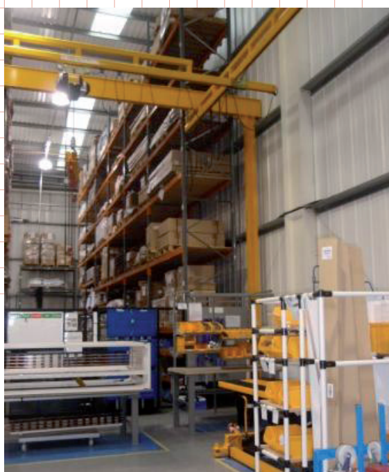
nízká výška příhradové konstrukce
