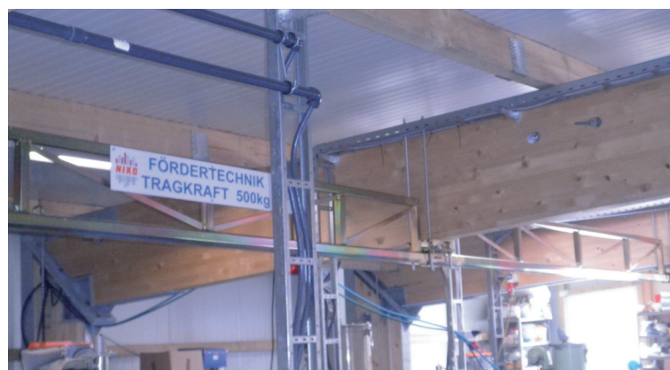
vyztužení kolejnice pomocí příhradové konstrukce (typ .045)
