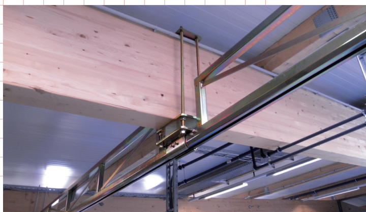
atypické kotvení k dřevěnému vazníku
