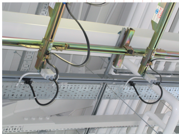
detail napojení kabelů na trolejové vedení
